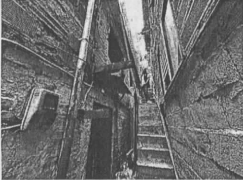
Imagen 1. Callejón donde se ubica la construcción.
