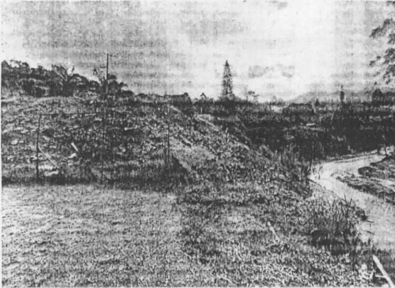
Ilustración 2. Lleno no técnico en zona de retiro de la quebrada La Miel.
