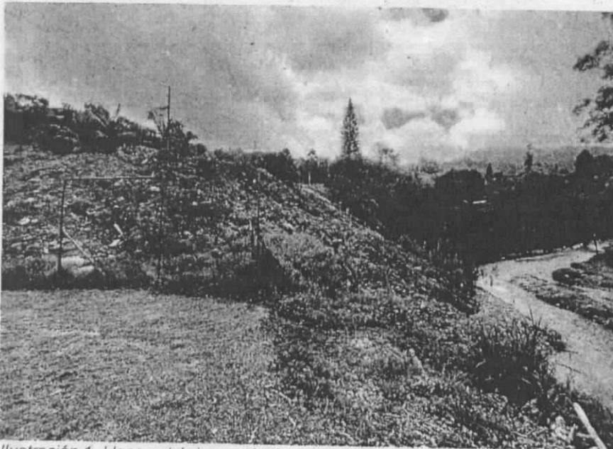
Ilustración 1. Lleno antrópico no técnico en la zona de retiro a la quebrada La Miel.
