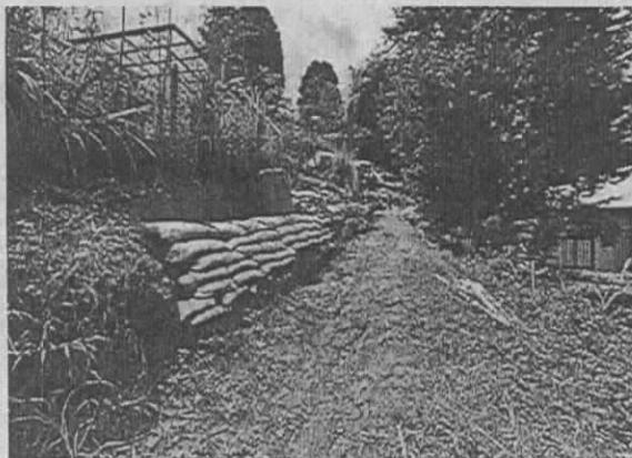
Imagen 1. Conformación de talud en costales.
