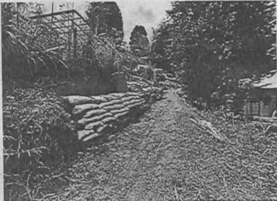
Imagen 1. Conformación de talud en costales.
