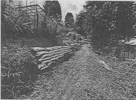
Imagen 1. Conformación de talud en costales.
