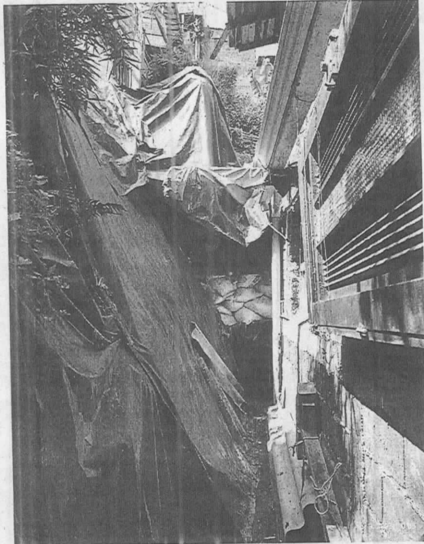
Figura 1. Talud cubierto con plástico
