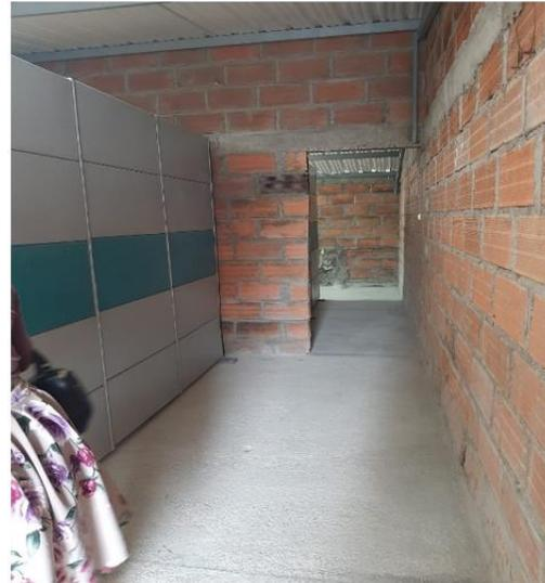
Se puede observar que el Archivo Histórico, su estructura no es adecuada, no cuenta con filtrado de aire, existen riesgos de humedad, se filtra el agua, la instalación no cuenta con pintura ni suelo de propiedades ignífugas de alta resistencia mecánica y desgaste mínimo a la abrasión como lo recomienda la ley.
