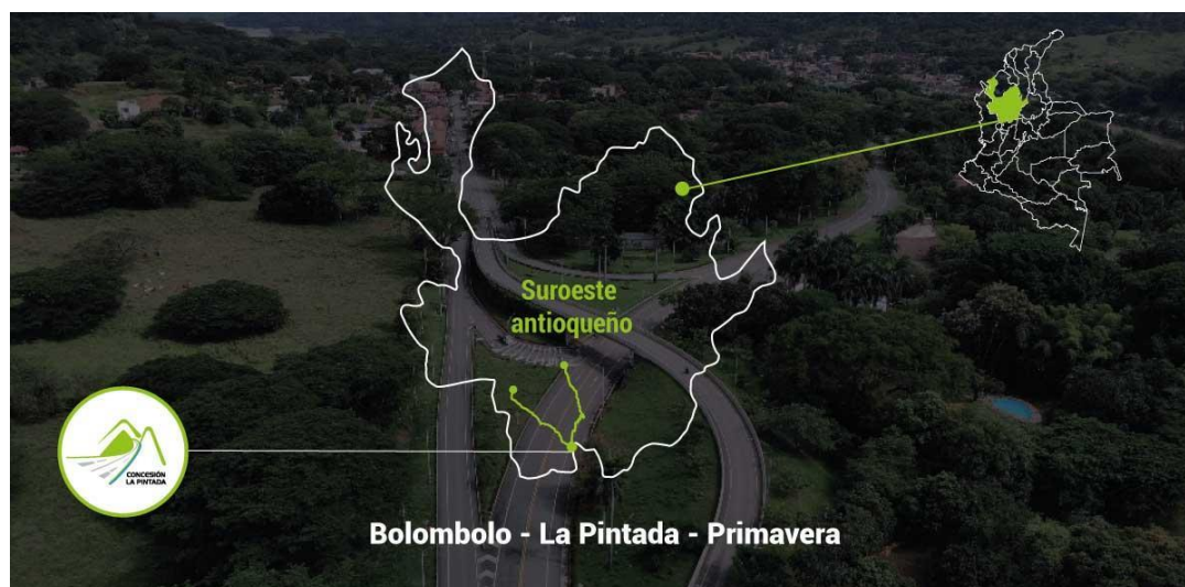
Ilustración 129. Localización obras Pacifico 2.
