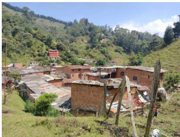
Figura 172. Viviendas del centro poblado La Valeria ubicadas sobre depósitos de deslizamiento.
