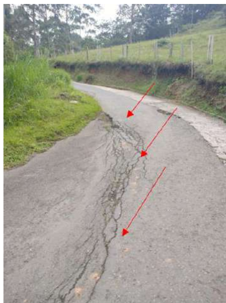
Figura 54. Fenómeno de deslizamiento lento localizado en la vía que va hacia el barrio Andalucía. Fuente: Estudio básico de amenazas Caldas (2023)
