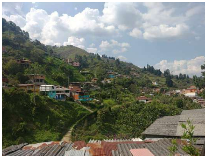
Figura 160. Ladera corta empinada. En suelo residual Fuente: Estudio básico de amenazas Caldas (2023)
