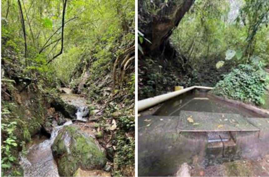
Figura 7-10. Fuente de abastecimiento y estructura de captación del acueducto Primavera.
