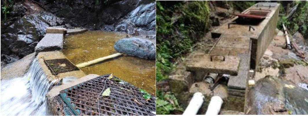
Figura 7-19. Captación y desarenador del acueducto Multiveredal.
