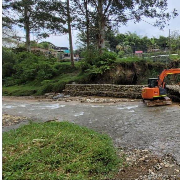
Imagen N°1. Imagen de muro en gaviones
